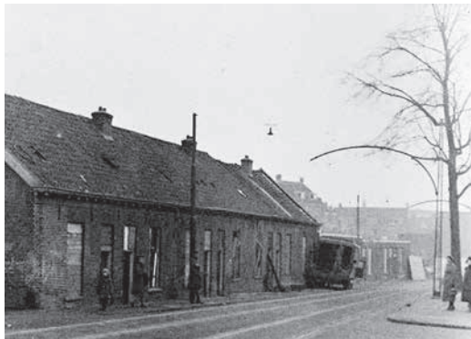
Arbeiderswoningen aan de Hommelseweg tegenover de St. Antonielaan in 1933. (Gelders Archief 1501-04-4224)
